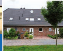
Schlüsselfertiger Bau von Mehrfamilienhäusern
