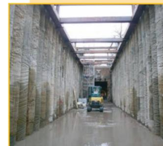
Baugrube mit Bohrfahlwänden
