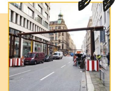
Wasserhaltung mit aufgeständerter Rohrbrücke
