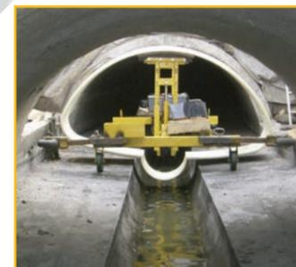
Einbringen eines Rohrs mit dem Rohreinzugswagen
