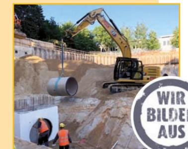
Kanalneubau und setzen eines Schachtes
