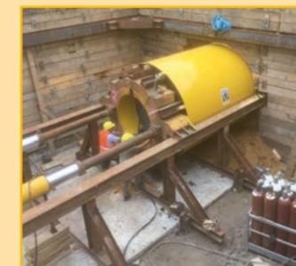
Rohrvortrieb im Zuge einer Erschließung
