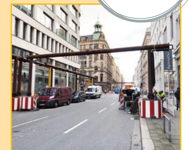
Wasserhaltung mit aufgeständerter Rohrbrücke
