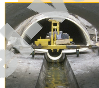
Einbringen eines Rohrs mit dem Rohreinzugswagen
